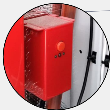
Controller del sistema antincendio
